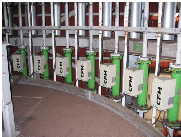
製鉄高炉における微粉炭流量測定装置の設置例
